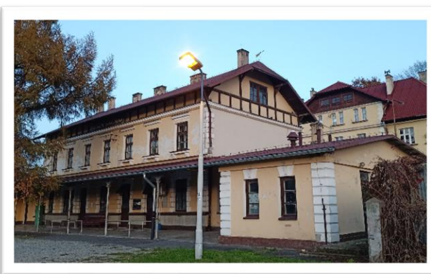
Fot. 45. Budynek Dworca Staroniwa (fot. Biuro ZIR)
